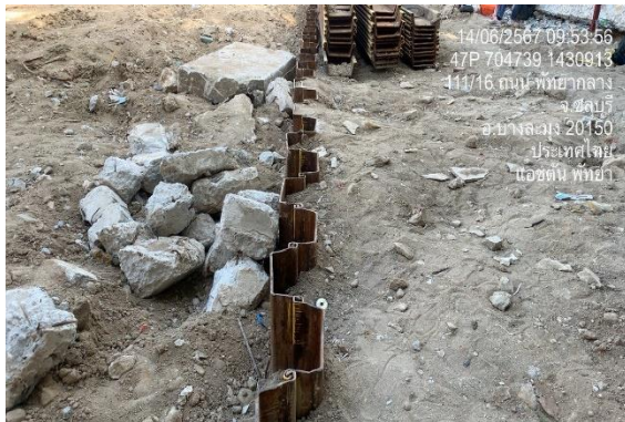
รูปที่ 5 Sheet Pile เพื่อป้องกันการชะล้างหน้าดิน (ปัจจุบันบ้นได้รื้อถอนเรียบร้อยแล้ว)
