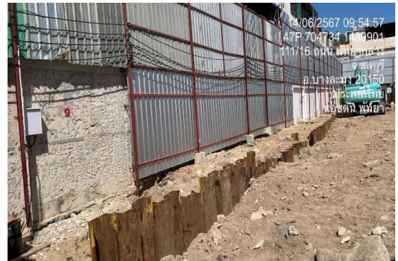
รูปที่ 5 Sheet Pile เพื่อป้องกันการชะล้างหน้าดิน (ปัจจุบันบ้นได้รื้อถอนเรียบร้อยแล้ว)
